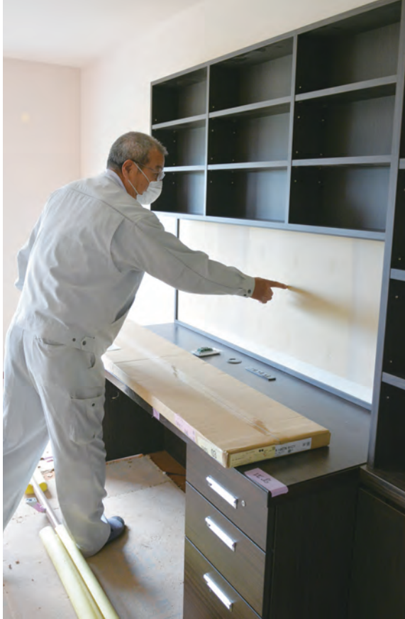
書斎の棚は造作し、隣の和寝室との間の壁は防音対策 をしました。
